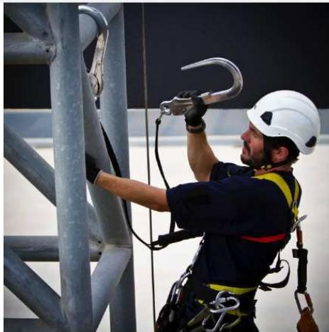
Ilustración 20: sistema anticaídas configurado con absorbica y ganchos MGO.
