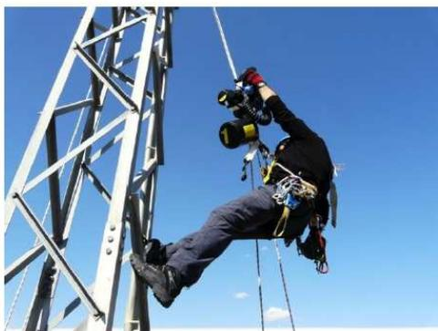
Ilustración 39: equipo de salvamento según norma UNE EN 341 tipo A
