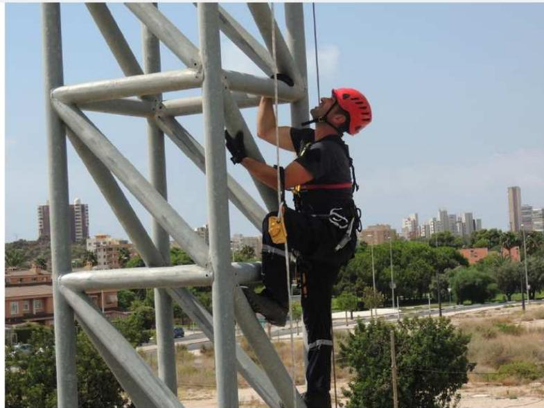
Ilustración 18: sistema anticaídas configurado con ASAP y línea de anclaje flexible 353-2.
